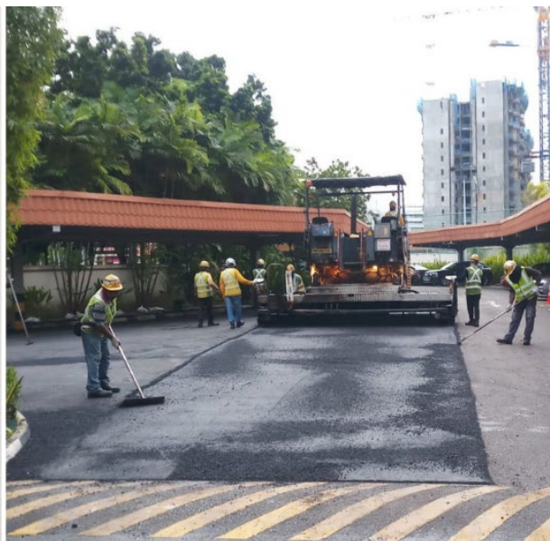
プラスチック道路施工現場
