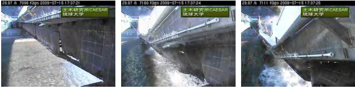
写真-8 鋼橋の塩害による落橋の連続写真*
